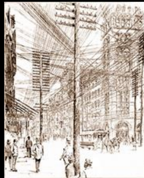
пренос на електрична енергија
